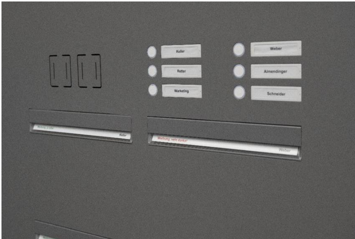
Flächenbündige Einwurfklappe in einer Türseitenteilanlage (Foto: Renz)
